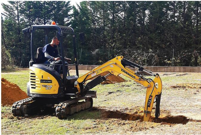
En première phase, les fondations, sont constituées chacune d'un bloc de béton d'environ un mètre cube renforcé en dessous par deux gros pieux vissés dans le sol jusqu'à plusieurs mètres de profondeur.
